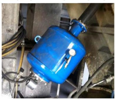
Na sua forma mais simples, um canhão de ar consiste de uma válvula de alta vazão de disparo rápido e um vaso de pressão. O trabalho é executado quando o ar comprimido (ou outro gás inerte) no vaso é instantaneamente libertado pela válvula. O CATEC70 representa a tecnologia mais moderna em termos de eficiência e potência para desagregar materiais que se acumulam em recipiente de armazenamento.
